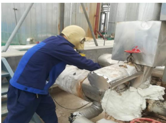
關閉泵進出口閥門
